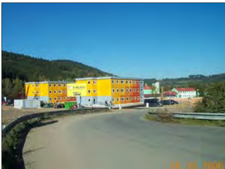
Poschla. Celkový pohled na Poschlu, vlevo v popředí upravená plocha bývalé skládce.
