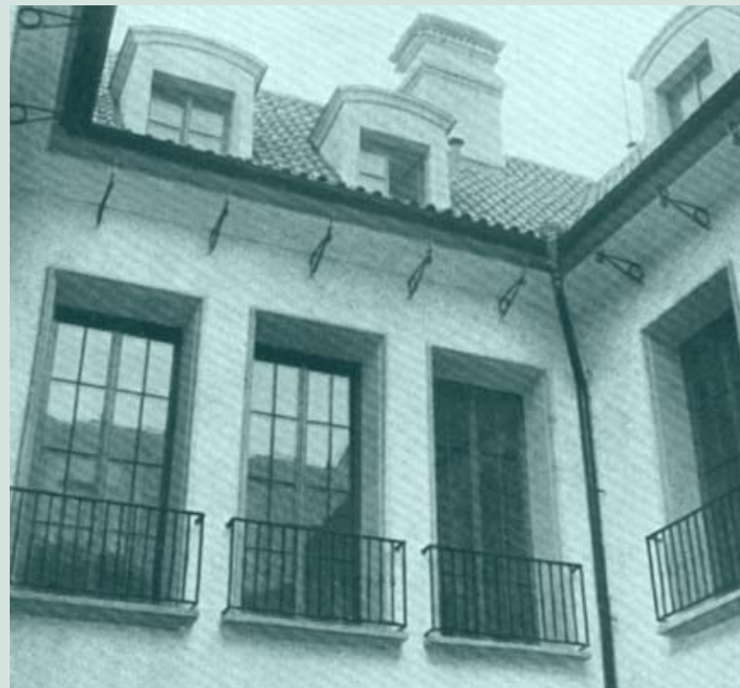
Detail z malého nádvoří po adaptaci, 1951
