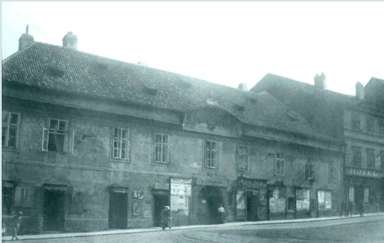
Dobový pohled na severní fasádu, cca 1916
